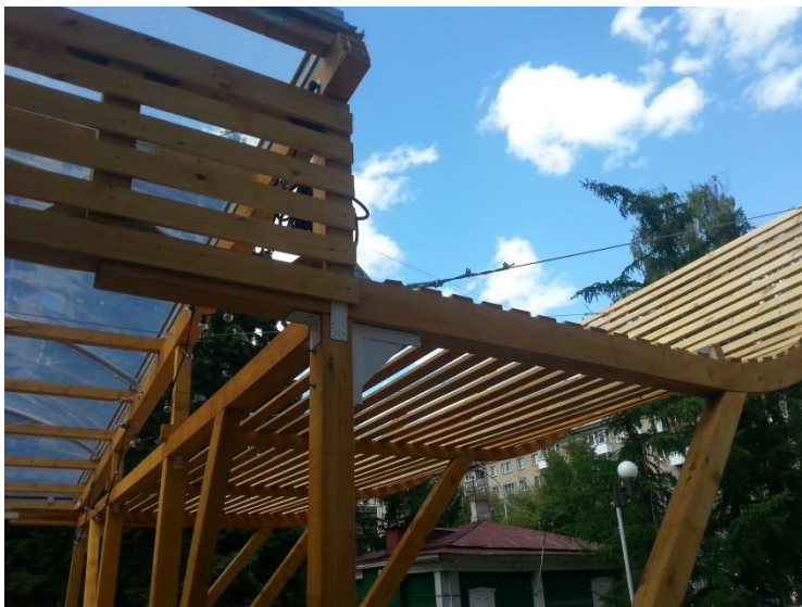
Летнее кафе с клеждощатыми и цельнодеревянными элементами каркаса (г. Новосибирск, ул. Ленина, 21) 400 кв.м. (руководитель – канд. техн. наук, доцент Павлик А.В.)
