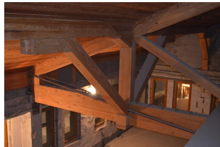
Гостинично–развлекательный центр «Зелёный бор» (г. Новосибирск), клеёдошатая ферма на деревянных накладках и болтах пролётом 18 м, её натурные испытания и уже возведённая конструкция (авторы – канд. техн. наук, доцент Павлик А.В., канд. техн. наук, доцент Прижукова Е.Л.)
