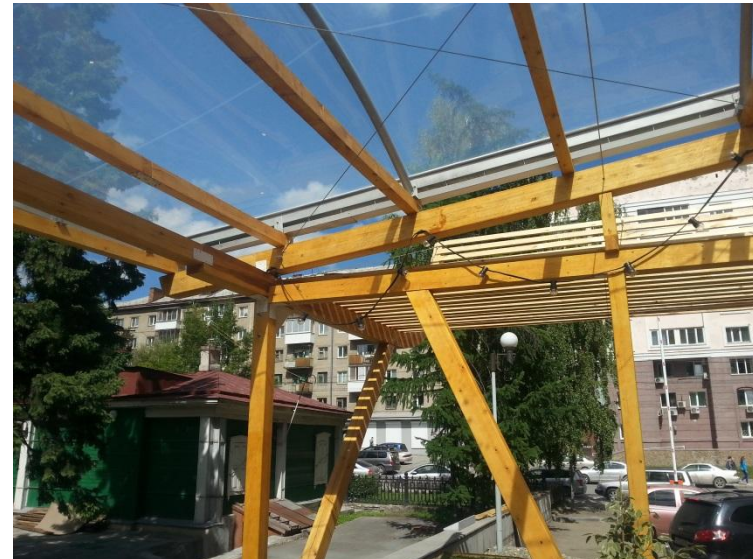
Летнее кафе с клеждощатыми и цельнодеревянными элементами каркаса (г. Новосибирск, ул. Ленина, 21) 400 кв.м. (руководитель – канд. техн. наук, доцент Павлик А.В.)
