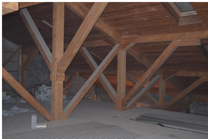
Гостинично–развлекательный центр «Зелёный бор» (г. Новосибирск), клеёдошатая ферма на деревянных накладках и болтах пролётом 18 м, её натурные испытания и уже возведённая конструкция (авторы – канд. техн. наук, доцент Павлик А.В., канд. техн. наук, доцент Прижукова Е.Л.)
