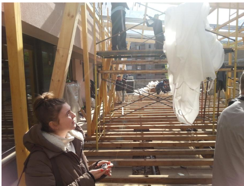
Летнее кафе с клеждощатыми и цельнодеревянными элементами каркаса (г. Новосибирск, ул. Ленина, 21) 400 кв.м. (руководитель – канд. техн. наук, доцент Павлик А.В.)
