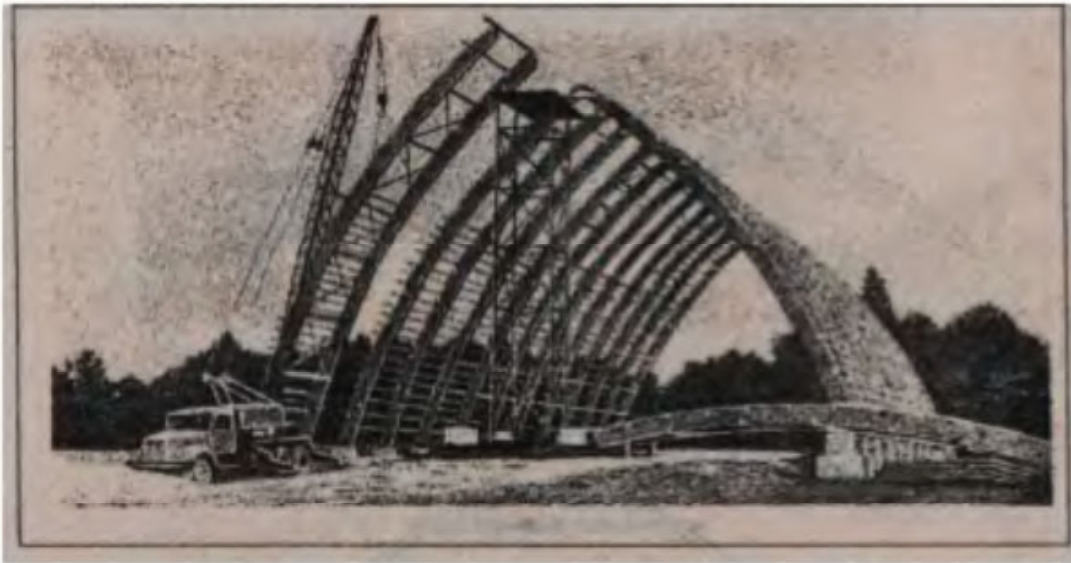
Рис. 29. Монтаж клееных стрельчатых арок с использованием монтажной башни
