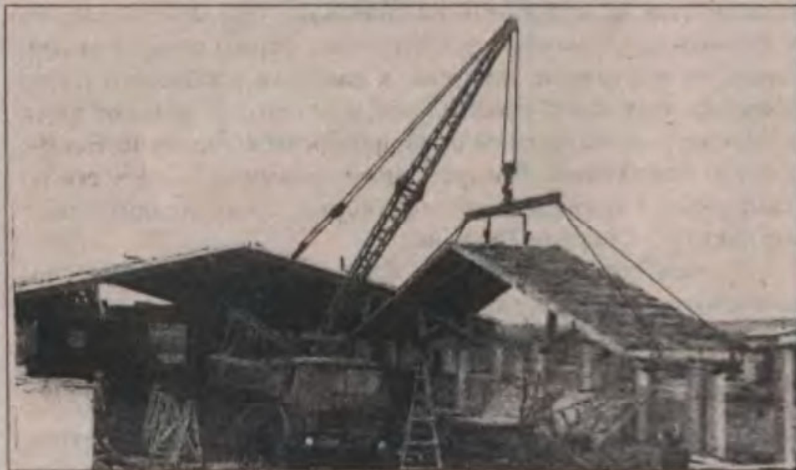
Рис. 26. Монтаж металлодеревянной блок-фермы автокраном
