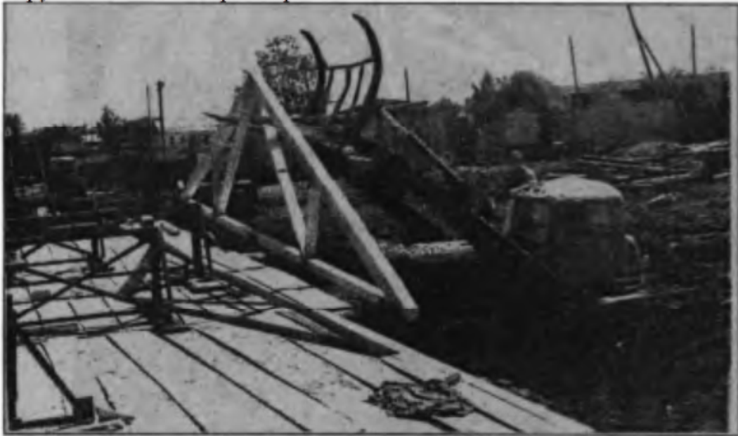
Рис. 18 . Транспортировка к месту монтажа треугольной цельнодеревянной фермы в построечных условиях
