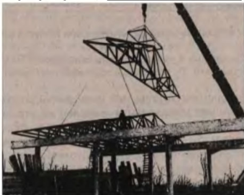
Рис. 15. Монтаж ферм укрупненными блоками 24
