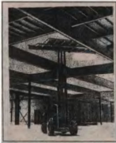
Рис. 10. Клефанерные ребристые плиты покрытия во время монтажа
