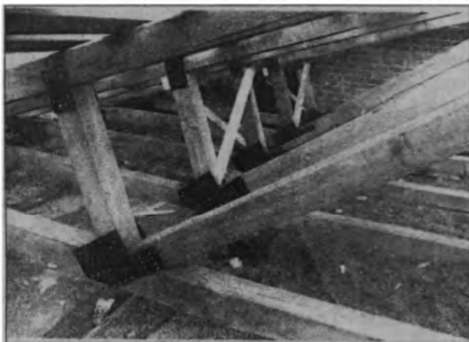
Рис. 21. Раскрепление ферм попарными связями после монтажа
