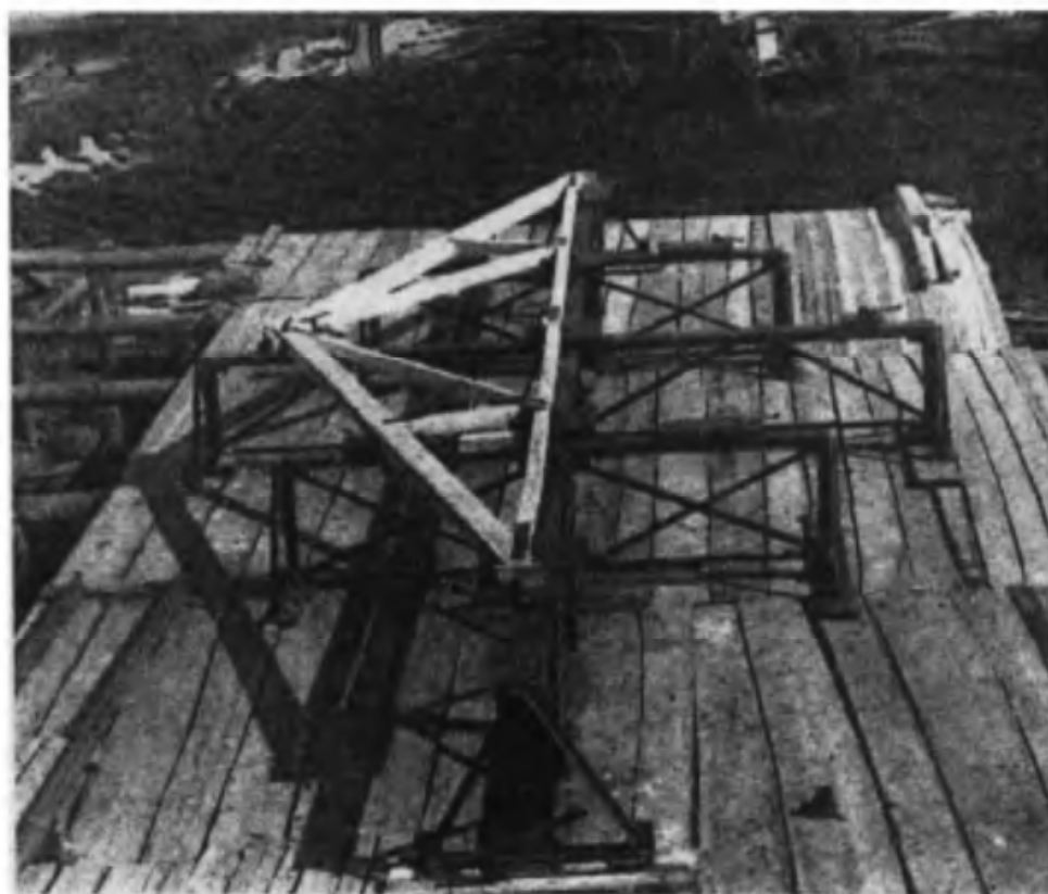
Рис. 16. Изготовление треугольной цельнодеревянной фермы
