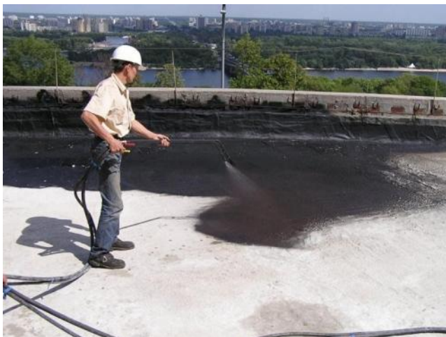
Устройство жидкой гидроизоляции
