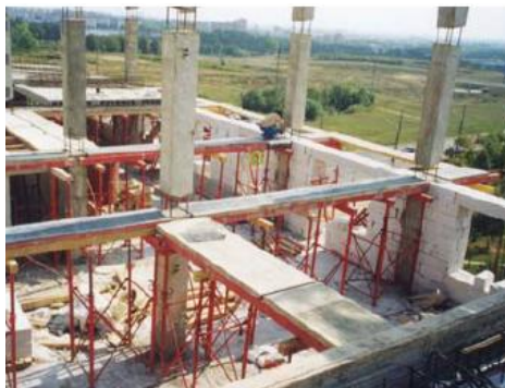
Рис. 3. Сборно-монолитная система «АРКОС»
