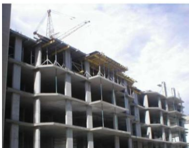
Рис. 1. Монолитный безригельный каркас
