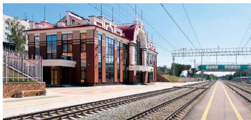
Строительство вокзала на станции Сеятель Западно-Сибирской железной дороги
