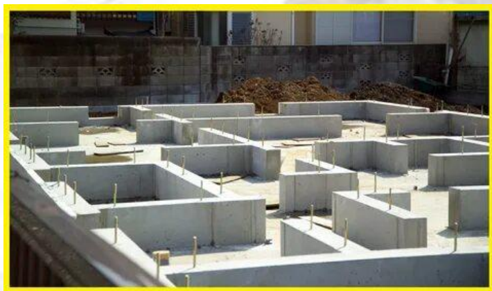
Монолитное бетонирование
